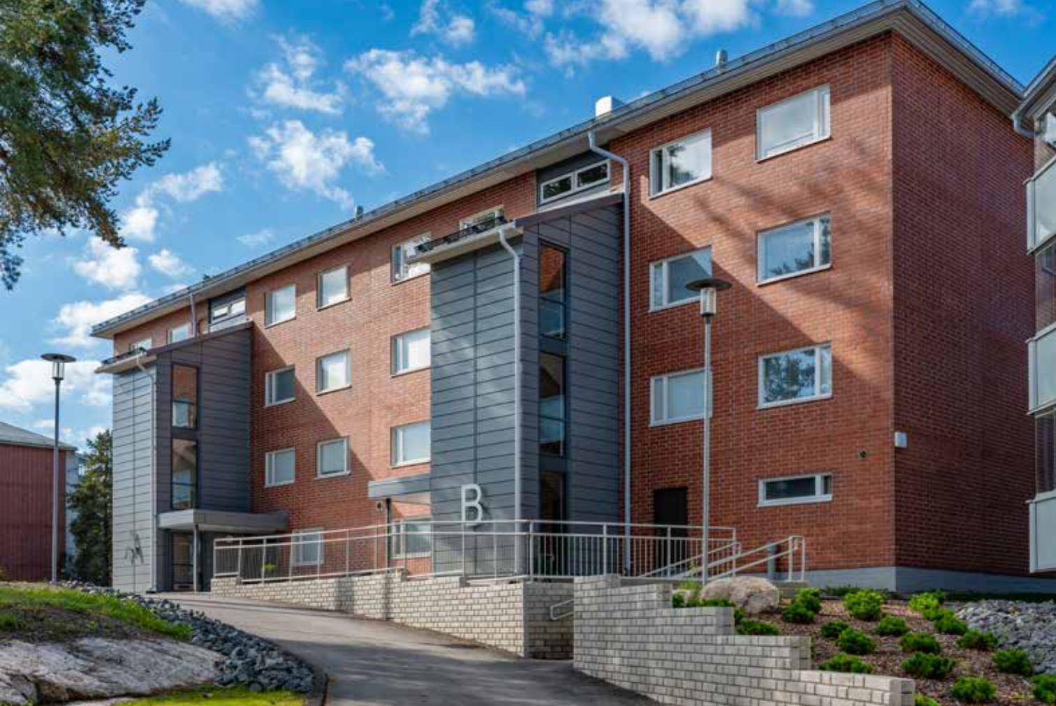
Marttilankatu 7 ja 9 -kiinteistöihin asennettiin uudet jälkiasennushissit.
