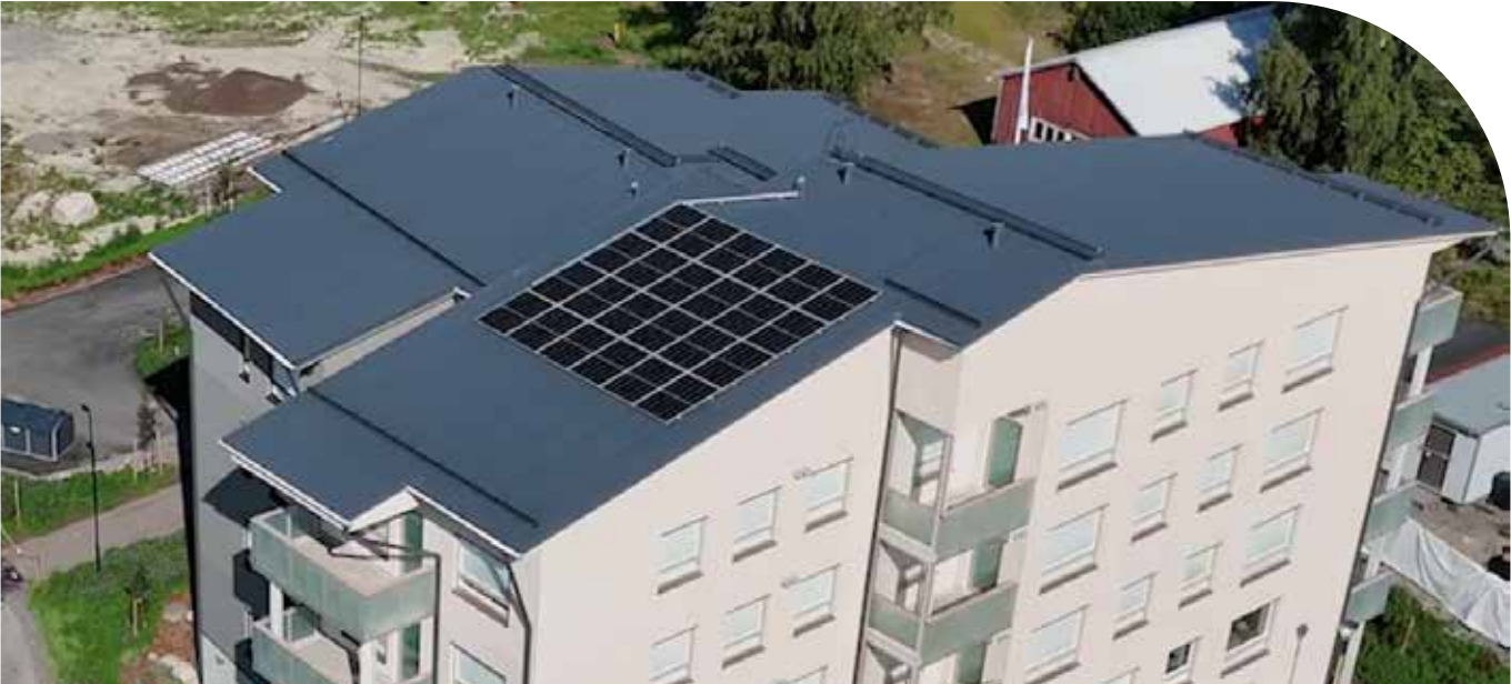
Pianonsoittajankatu 6 -kiinteistössä on aurinkovoimala, joka on vajaassa vuodessa tuottanut noin 8 000 kWh sähköä, joka vastaa lähes puolta siitä, minkä kiinteistö itse kuluttaa.
