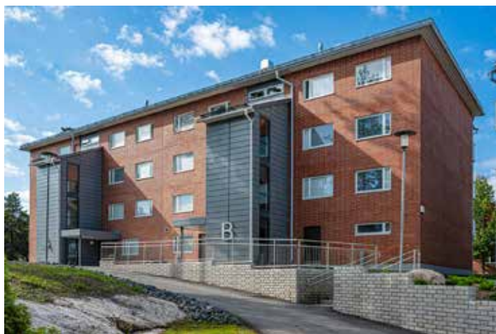
15 MARTTILANKADUN KAHTEN KIINTEISTÖÖN ASENNETTIIN HISSIT
