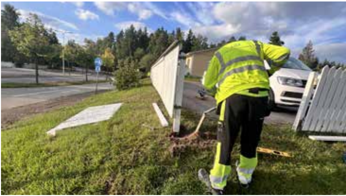
Sorsakorventie 11-13 aitojen korjaus
