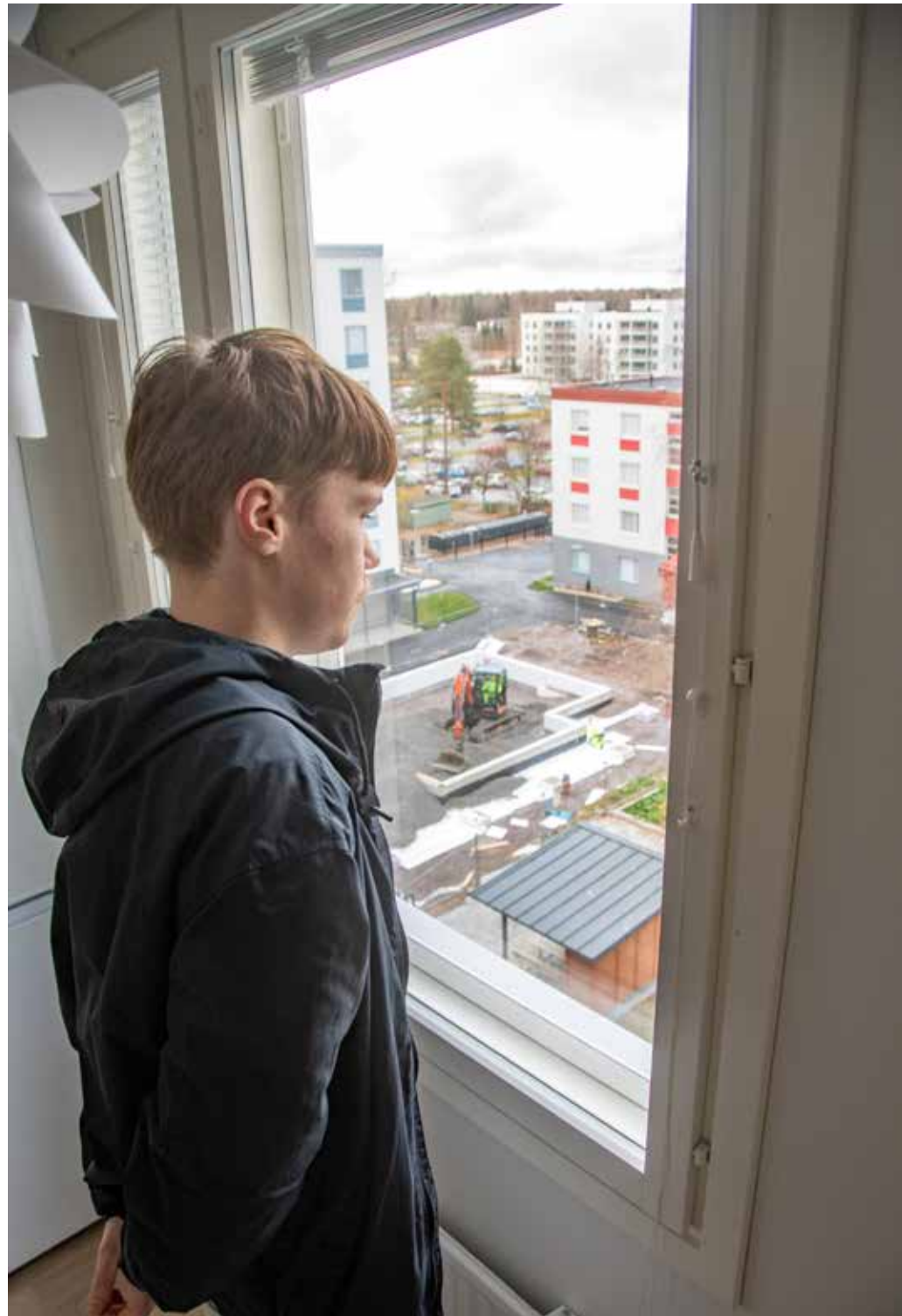
Ikkunasta näkyy, kuinka kerhorakennusta rakennetaan pihamaalle.
