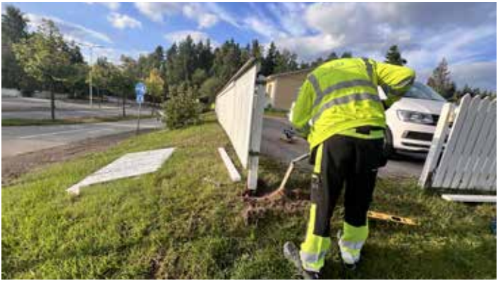
Sorsakorventie 11-13 aitojen korjaus
