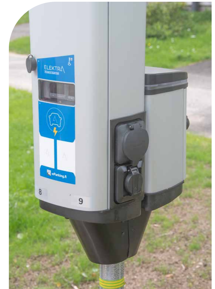
11 kW Type 2 ja 3,6 kW suko-pistokkeellinen sähköauton lataustolppa
