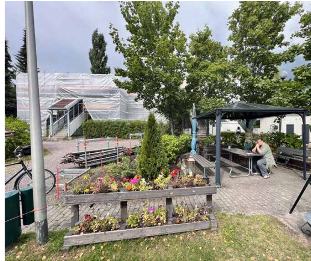
Tänä vuonna Metsäladontie 1:llä tehtiin remonttia. Marja Liisa Haverinen katoksessa, jonne asukkaat kokoontuvat.
