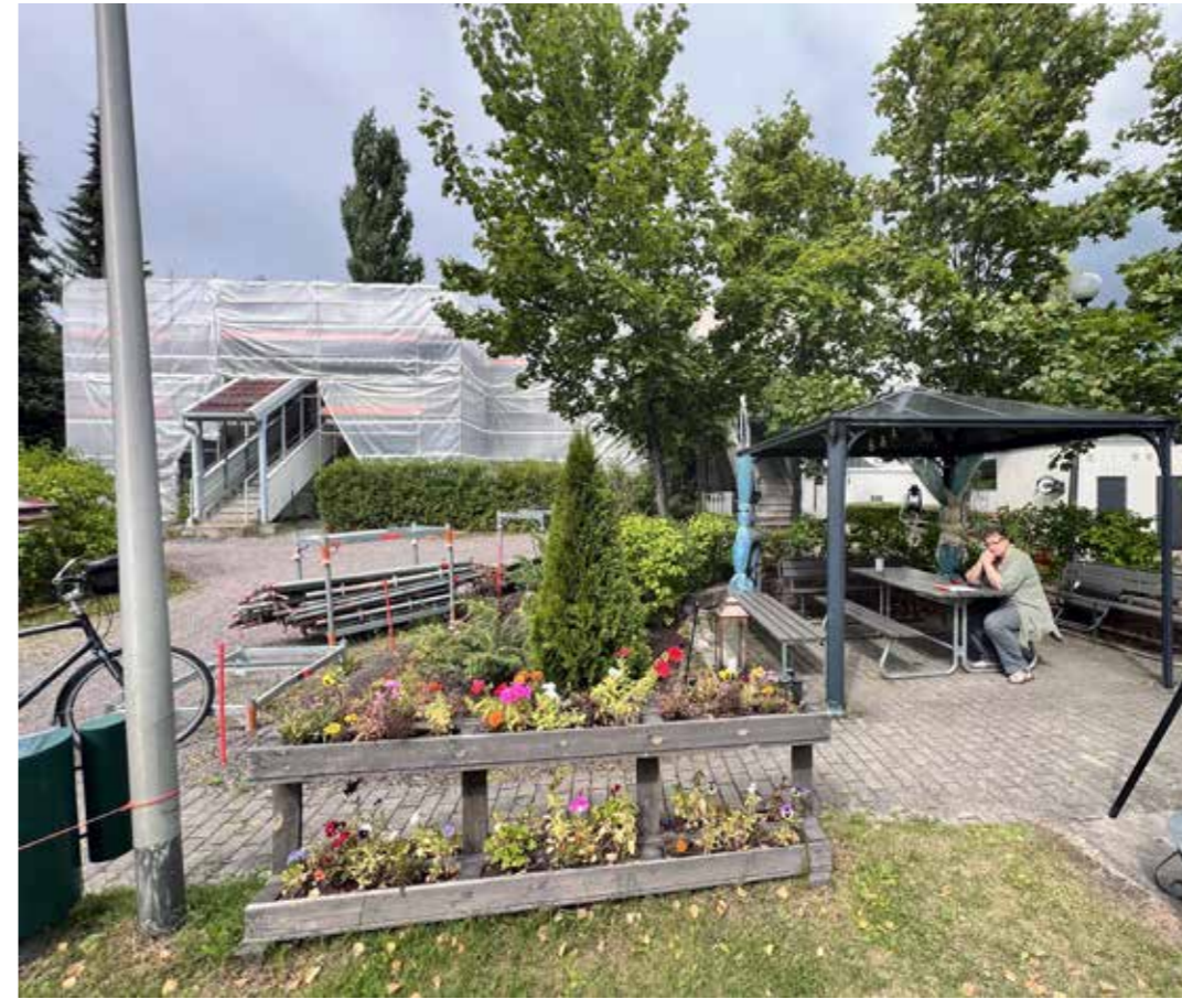
Tänä vuonna Metsäladontielle tehtiin remonttia. Marja Liisa Haverinen katoksessa, jonne asukkaat kokoontuvat.
