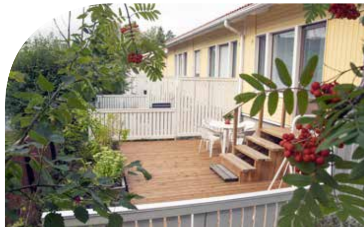
Tierantie 3-5:ssä rakennettiin uudet terassit 30 vuotta asuneille vuokralaisille.
