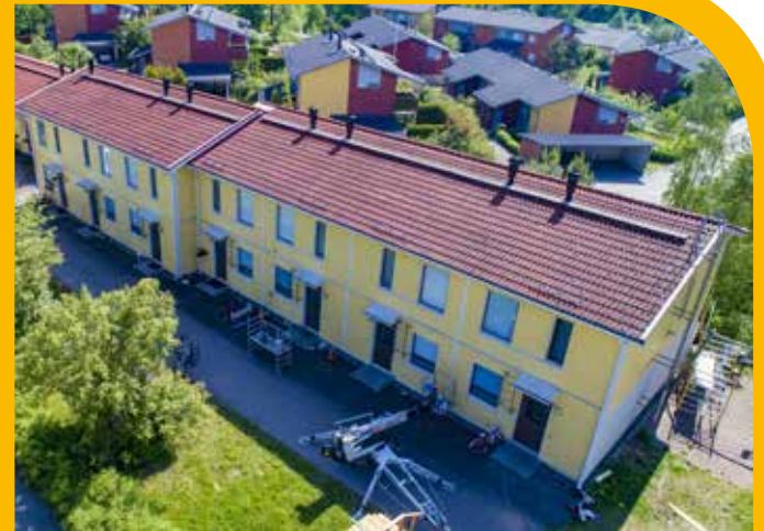
Tierantie 3-5:ssä maalattiin julkisivut ja uusittiin kattotiilet.
