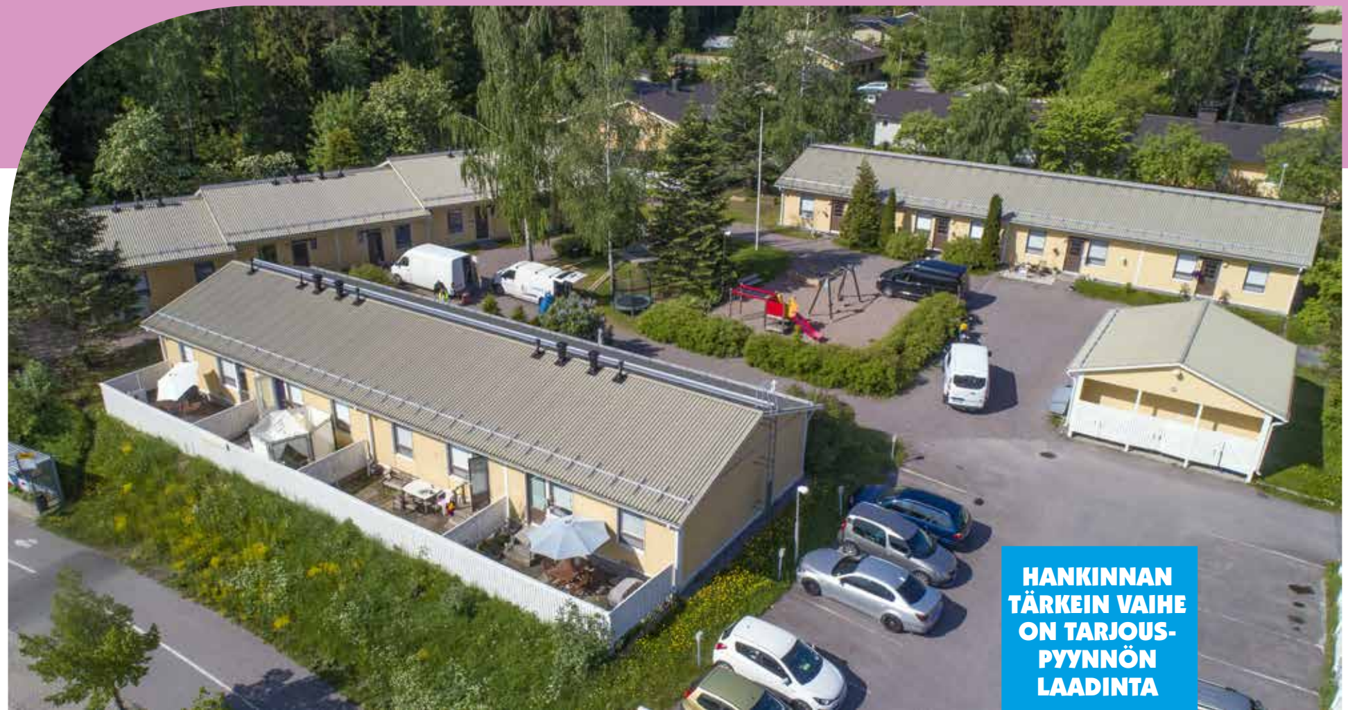
Sorsakorventie 11-13:ssa uusittiin käyttövesiputket.
