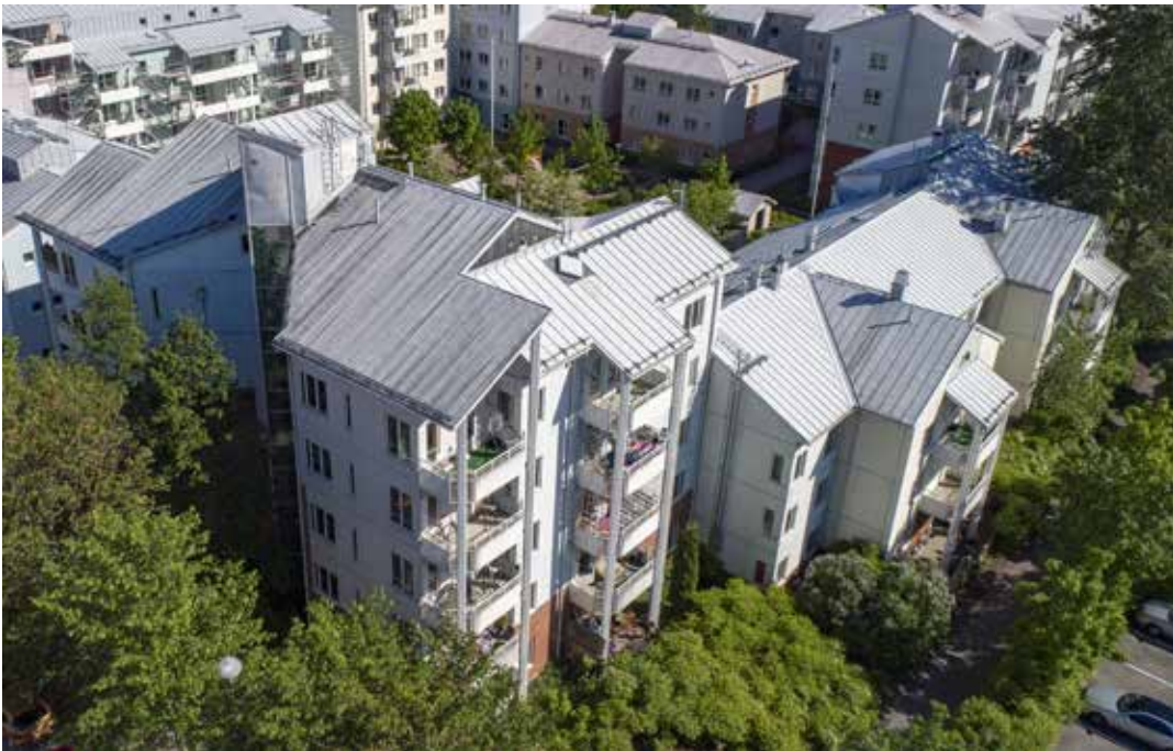
Santaniitynkadun ilmakuvassa näkyy, kuinka metsittyä aluetta on. Nyt asuntoja on 39, remontin jälkeen 57.
