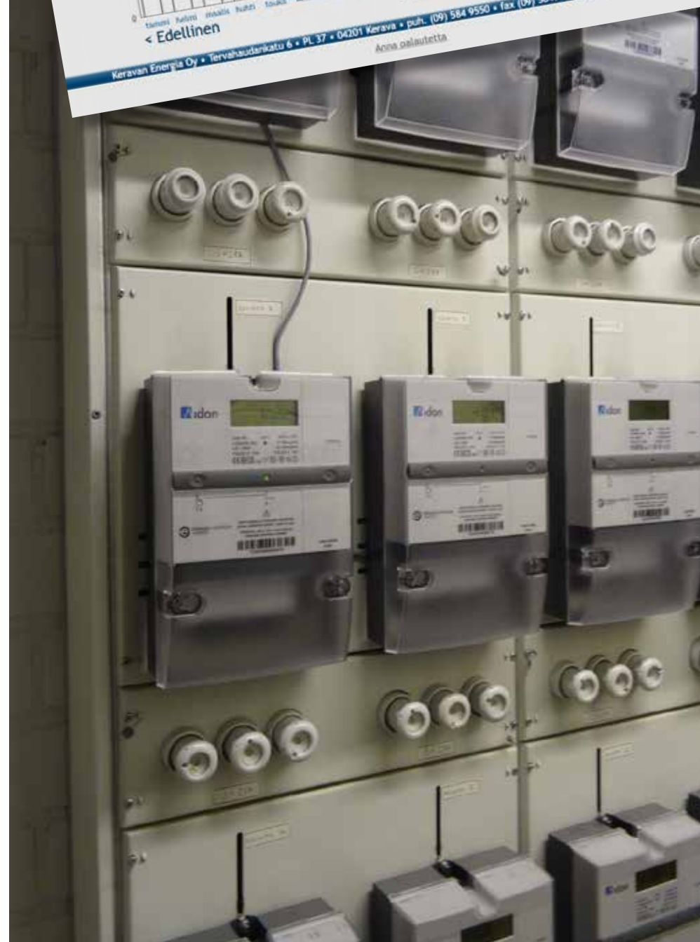
Asunnoissa on nykyisin etäluettavat sähkömittarit.
