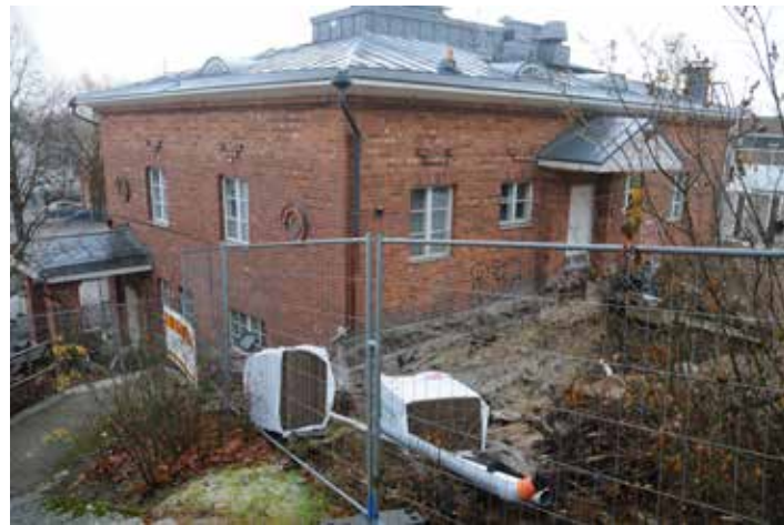
Kosteusongelmia ratkottiin asentamalla uudet salaojat.
